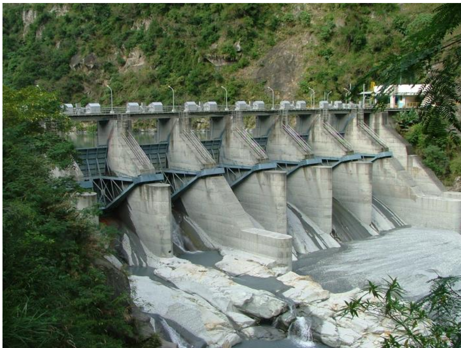
圖一六四 溪畔發電廠
